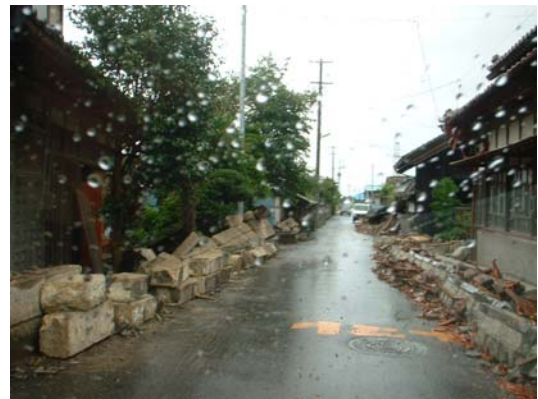
図-6.6 通学路に面したブロック塀や石塀倒壊
