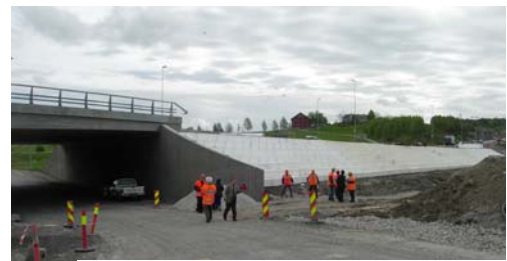
スウェーデン国境のEPS盛土施工現場
