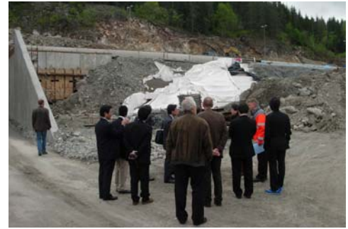
オスロ市内のEPS盛土施工現場
