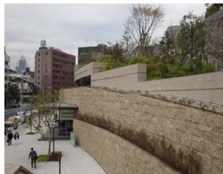
写真-5.1 建築屋上緑化の事例(都内)
